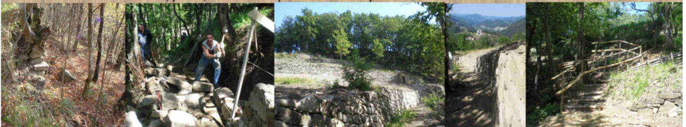
I sentieri sui terrazzamenti, prima, durante e dopo i lavori di recupero.
